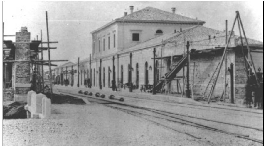
I lavori del primo ampliamento del fabbricato viaggiatori (1882-1884).
