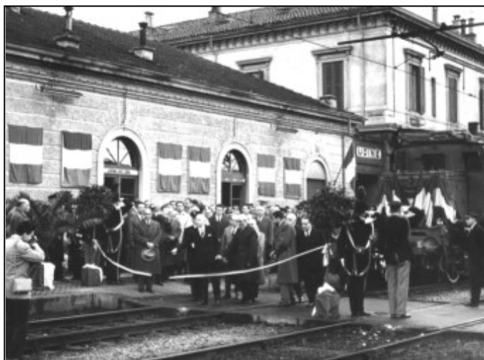
L'inaugurazione della trazione elettrica sulla Udine-Venezia (arch. DLF)
