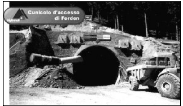
Sopra. Fervono i lavori per rispettare la scadenza del 2007 (foto BLS AG)
