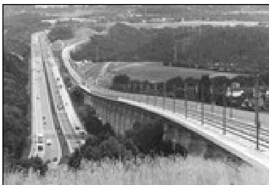
L'Hallerbachtalbrücke, il ponte più lungo della tratta (foto DB AG)
