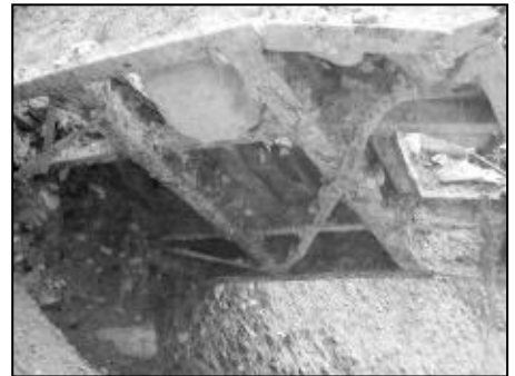
La struttura del ponte
