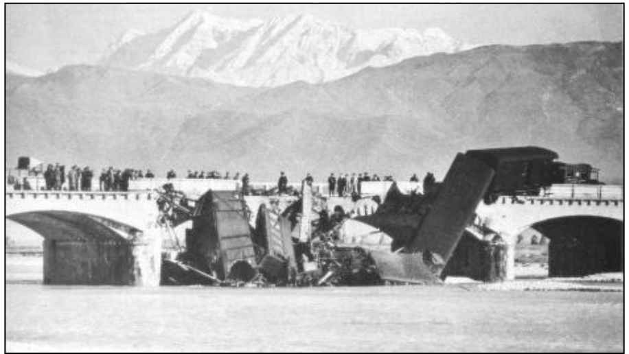
Il disastro del ponte del Torre (coll. D. Carlutti)
