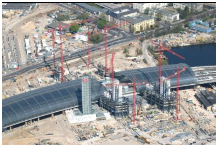
La nuova stazione centrale di Berlino in costruzione (foto DB)
