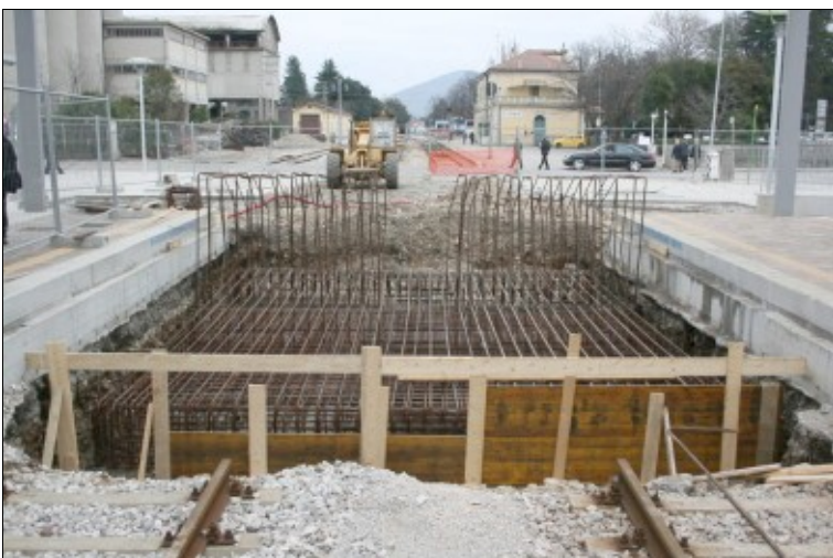
Si armano le fondazioni dei paraurti che sanciranno il termine della Ferrovia Udine-Cividale (foto D. De Anna)
