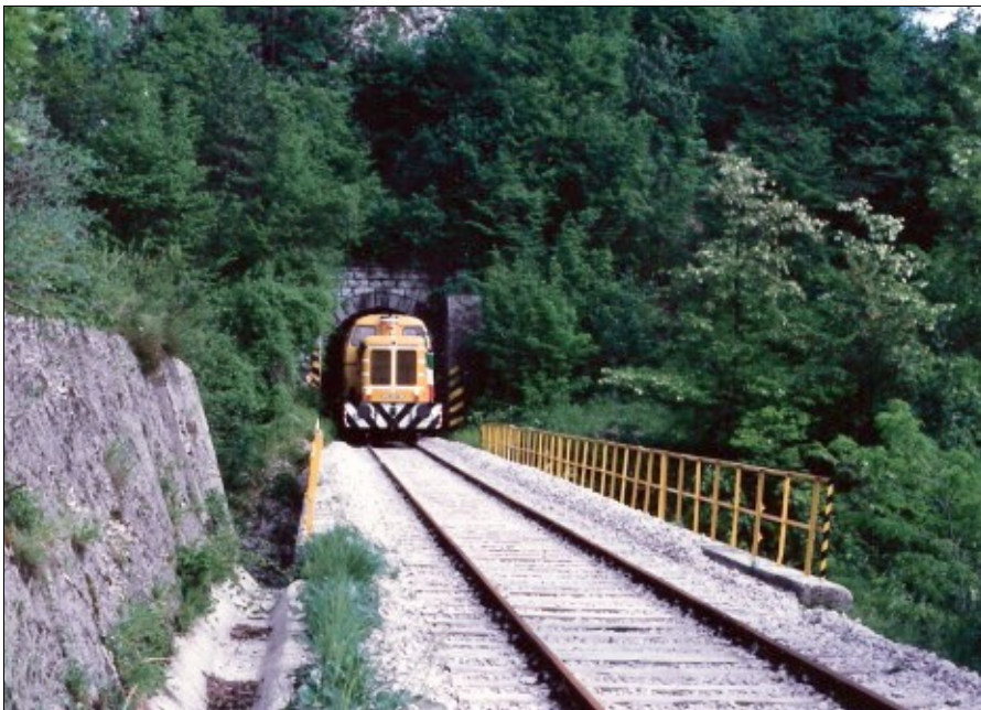
La Ferrovia Carnia-Tolmezzo è inserita nella proposta di LR. Il 5 giugno 1987 il treno inaugurale della ricostruzione della linea come raccordo ferroviario esce dalla galleria di Sassotagliato (foto C. Canton)
