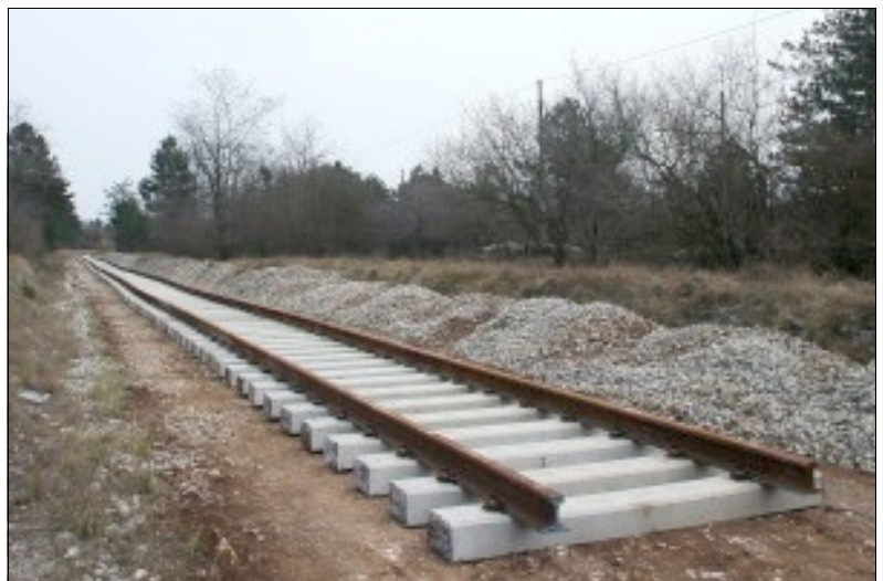
La posa dei binari per ricollegare il Terminal Intermodale di Ferneti con la rete RFI (foto L. Klobas)
